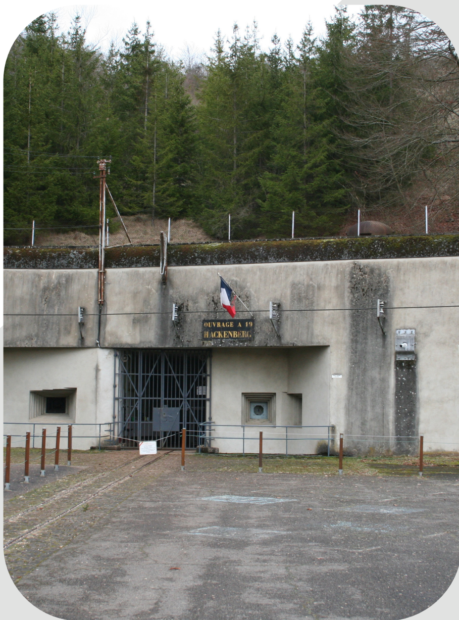
Ouvrage du Hackenberg, Veckring
